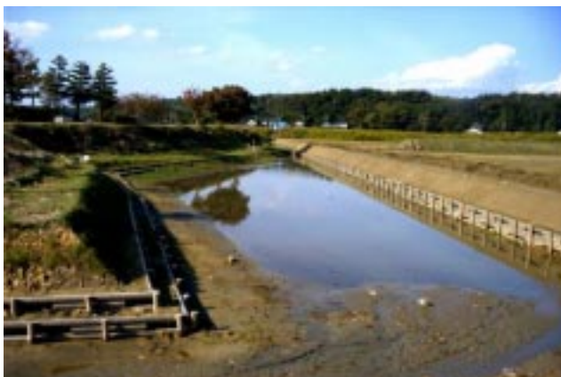
- 施工直後の板柵排水路（志賀町末吉） -
