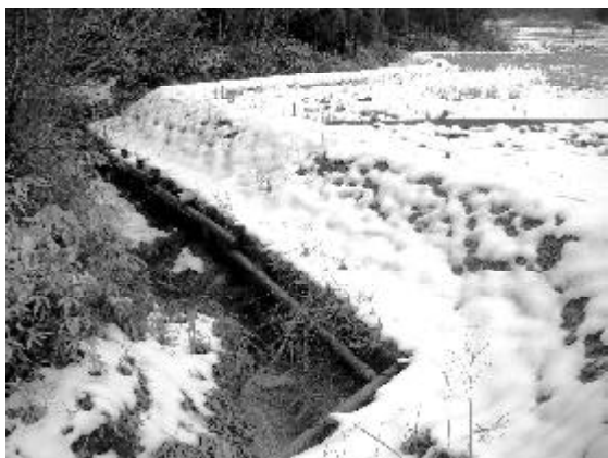
丸太と板を使って改修された排水路
