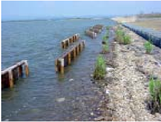
写真1 河北潟で取り組まれている自然再生事業のひとつ（石川県が湖岸整備にあたってヨシの植栽と波防壁の設置をおこなった）
