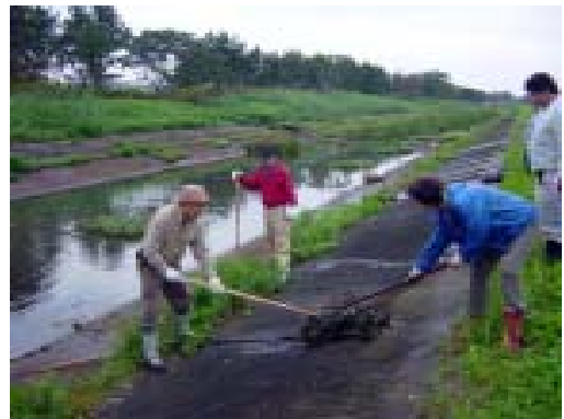
濡れたコンクリートマットの護岸上は、滑って立つこともできなかった。草があるところに足を置き、慎重に作業が進められた。
