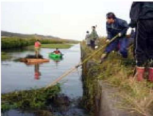
“いかり”や“いかだ”などの道具が開発され、作業効率があがっていった。陸と水面を切り離れた垂直な護岸では草に近づくこともできなかったが、試行錯誤されてより良い方法が生み出された。
